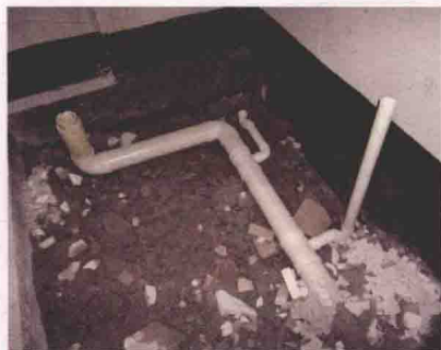
图1-7 考察 水路施工现场
