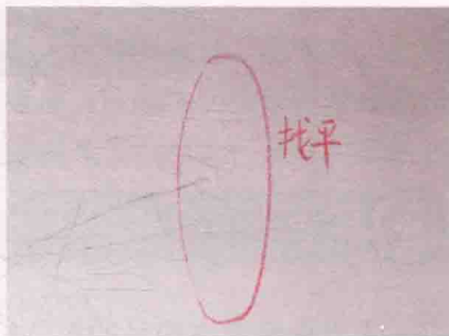
图1-15 验收 检查墙壁是否平整
