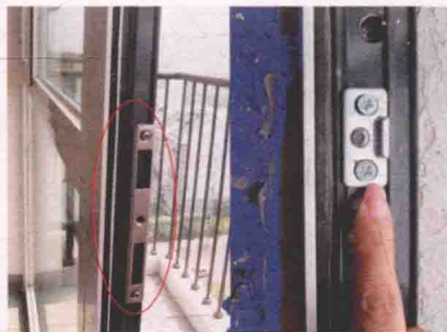
图1-14 验收 检查门的开启关闭是否顺畅，房门的插销、门销是否完好
