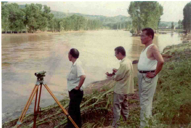
沁源县“93804”暴雨洪水发生后,省水文总站和分站派员紧急赶赴孔家坡水文站协助测报。图为1993年8月6日省水文总站副站长郝苗生和分站胡美珍、樊克胜在测验断面运筹洪水测验。
