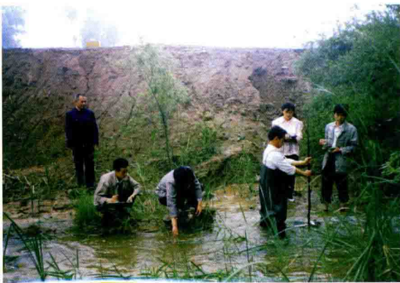
分站原副站长霍葆贞与技术人员为漳泽水库大坝抢险进行渗漏量和排沙量监测(1990)
