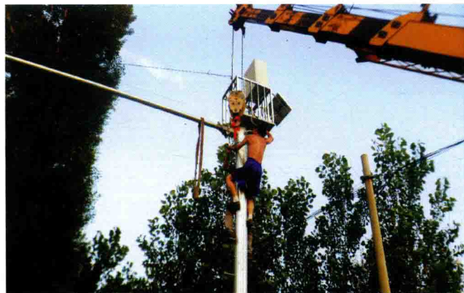
副局长药世文在中小河流监测系统项目建设现场施工(2012)
