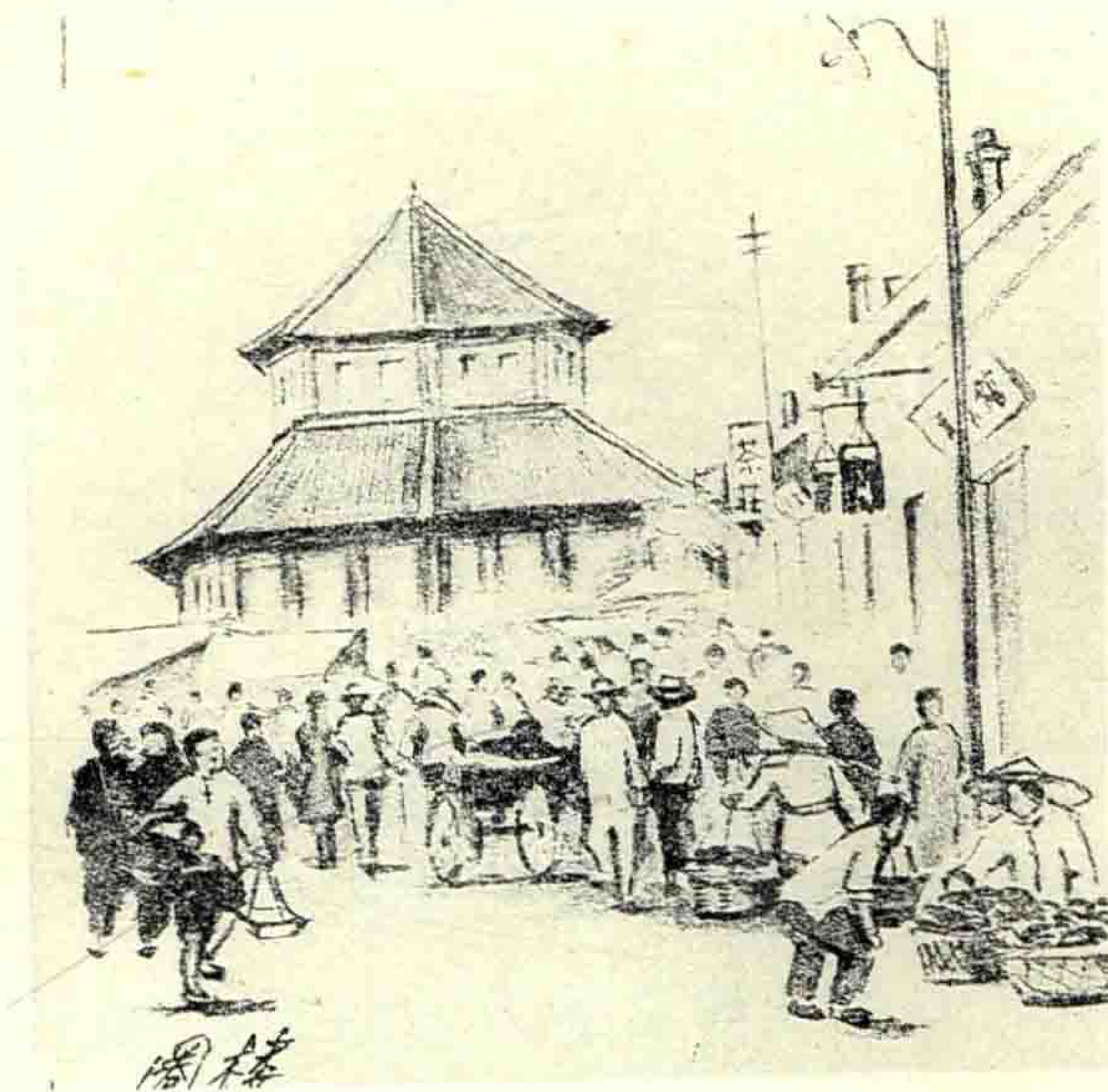
拆除前的东关圈楼原貌（速写）
