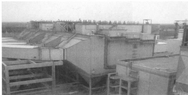
图 1-2 华电新乡宝山电厂电袋除尘器
