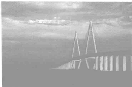
e)杭州湾大桥(主桥为斜拉桥)
