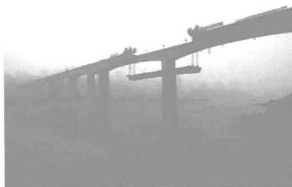
b)重庆石板坡长江大桥复线桥(连续刚构桥)
