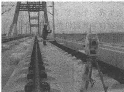
图 1-15 轨检小车用于无砟轨道精调
