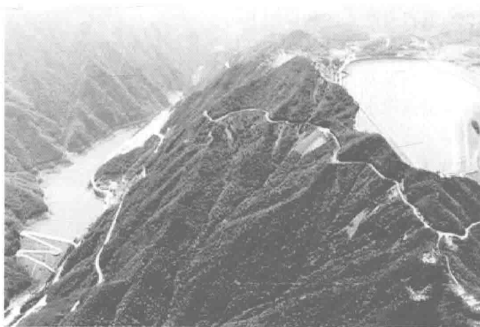
图 1-2 抽水储能电站俯瞰图
