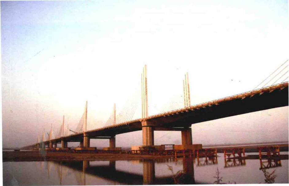
2006 年 11 月 28 日，大广高速公路开封黄河大桥建成通车（河南省交通运输厅供稿）
