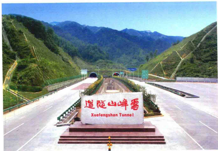
2007 年 11 月 10 日建成通车的湖南省邵怀高速公路雪峰山隧道（湖南省交通运输厅供稿）
