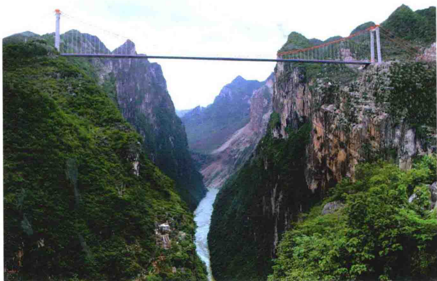
贵州关岭至兴义高等级公路北盘江特大桥（贵州省交通运输厅供稿）
