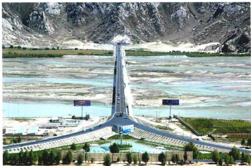
拉贡机场拉萨河特大桥（刘春辉摄影）
