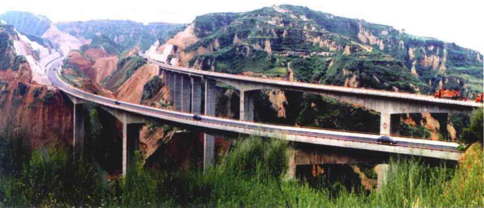
大运高速祁县至临汾段灵石石村沟特大桥（师国梁摄影）
