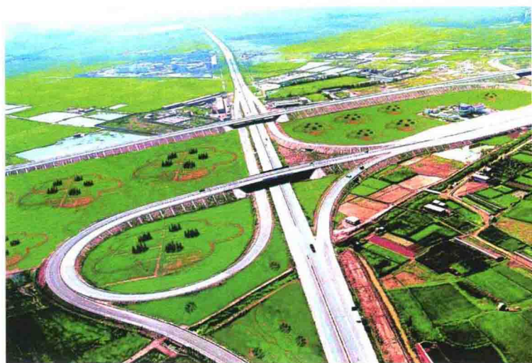
宁夏第一 高速公路——姚 叶高速公路银川 立交桥（宁夏交 通运输厅供稿）
