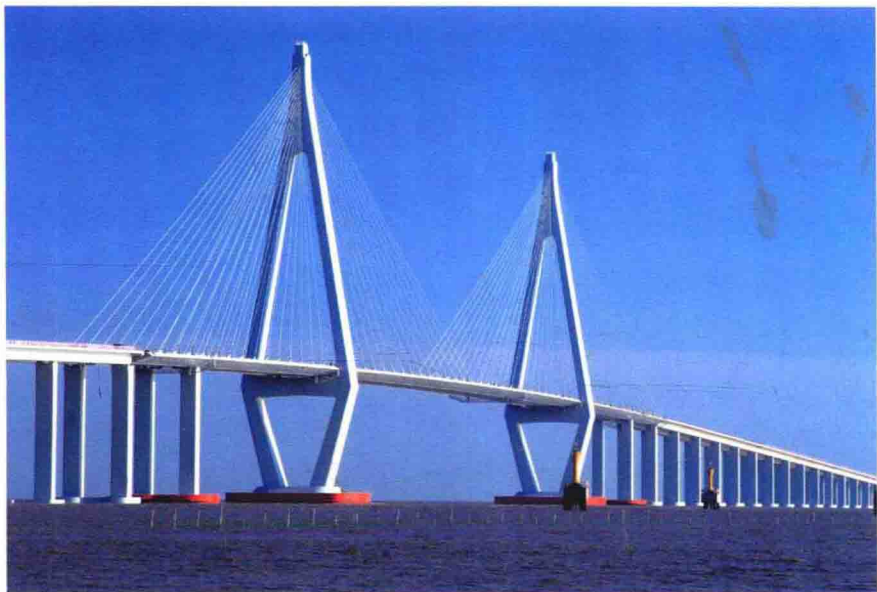
杭州湾跨海大桥（浙江省交通运输厅供稿）
