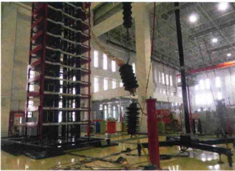
图 1 整只避雷器残压试验照片
