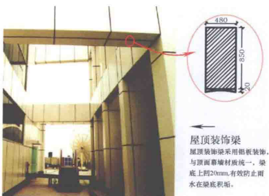
图 4.3.5-2 梁底上凹 20mm,有效防止雨水在梁底积垢
