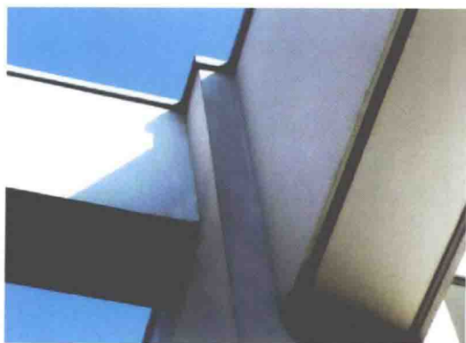
图 4.3.5-3 屋面构架双重滴水处理
