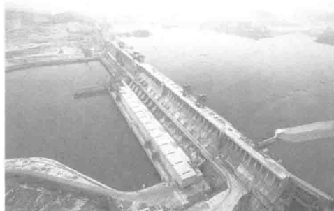
图 1.3 三峡大坝(摘自搜狗图片)
