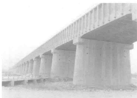
图 1.7 南水北调漕河渡槽（摘自百度图片）
