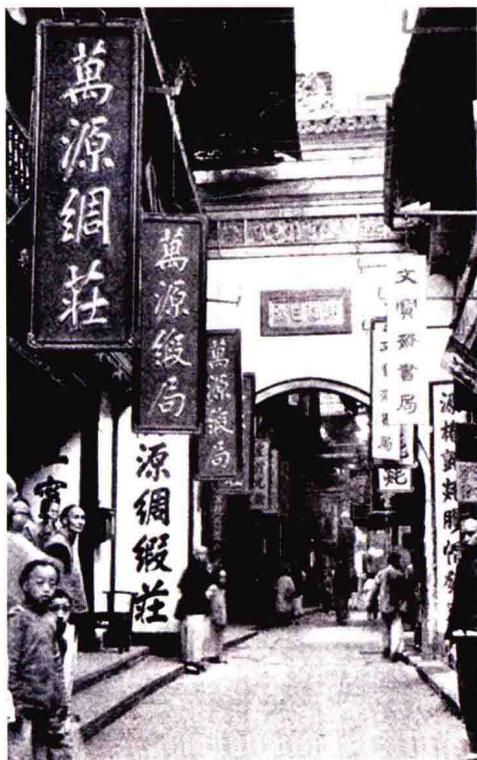
图 1-2 杭州老街, 店招牌匾林立, 固定的商业模式。
