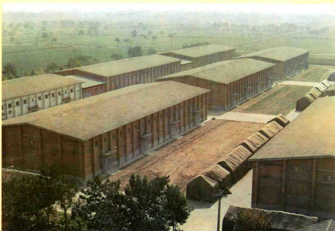
△ 市第一粮库修建的基建房式仓群
