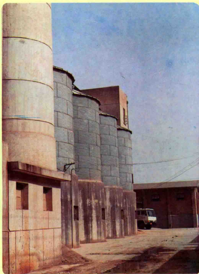
左图为武功县贞元 面粉厂的钢板仓
