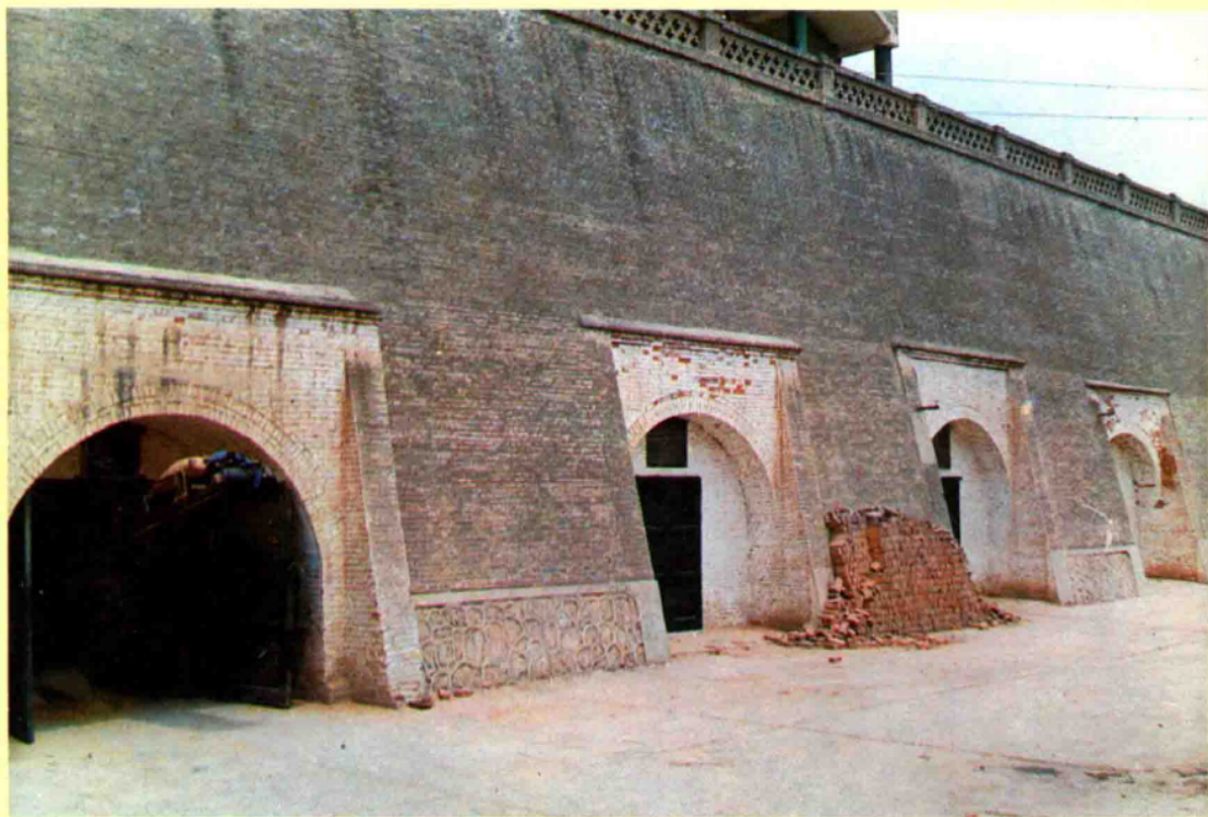
△礼泉县北屯粮站的地下仓
