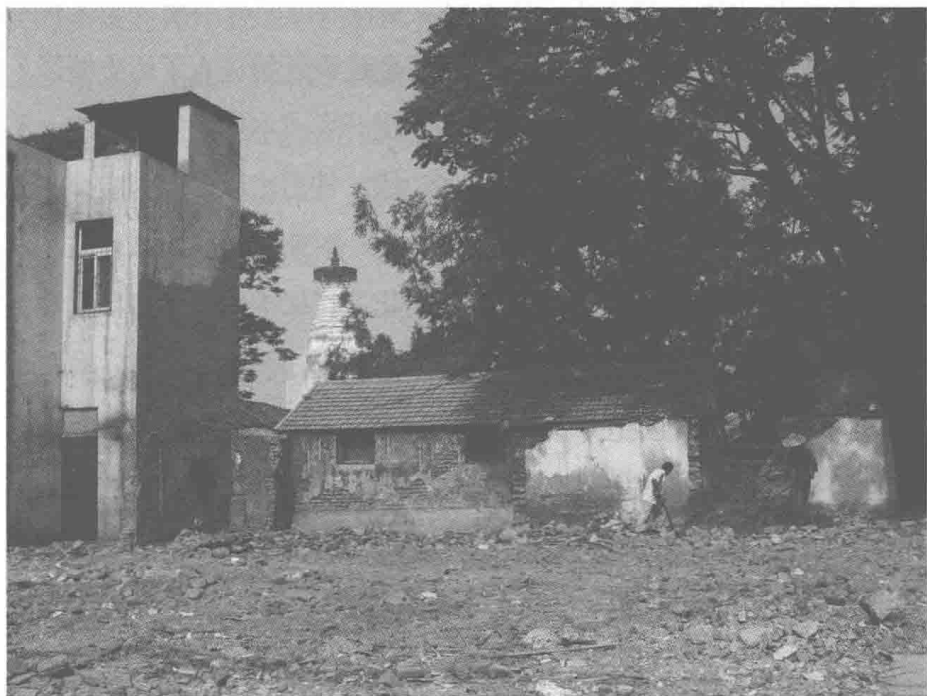
北京白塔寺及周边地区拆迁改造情况
