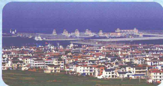
吕四中心渔港扩建工程
