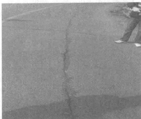
图 1-4 纵向裂缝
