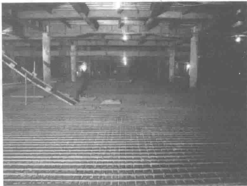
图7 逆作法底板施工
