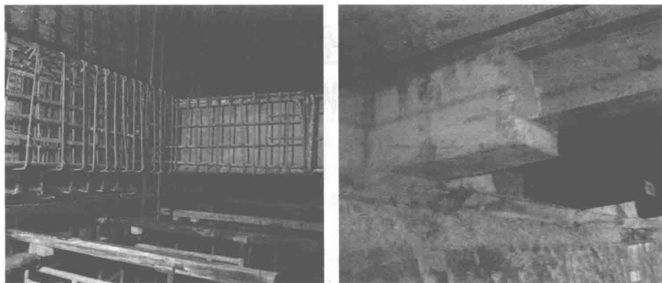
图 17 框架梁与连续墙连接大样
