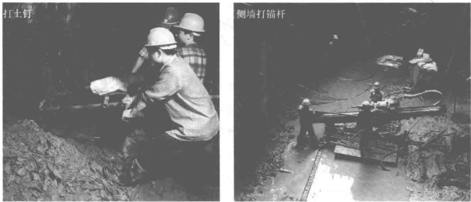
图 11 围护结构施工现场
