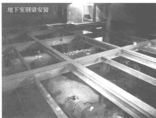
图 14 地下室组合楼盖的钢结构安装
