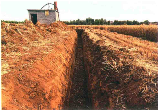
图 1-30 直埋式电缆沟槽施工
