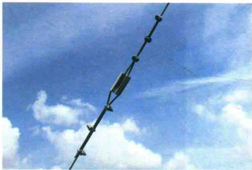
图 1-21 采用 J-9 拉紧绝缘子工艺
