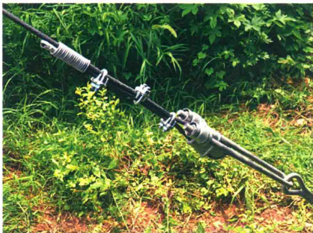
图 1-18 UT 型线夹安装
