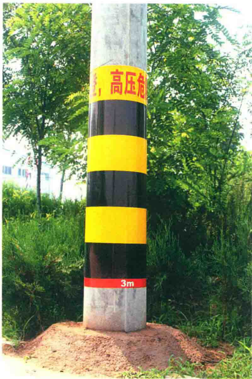
图 1-9 电杆埋深及杆基回填
