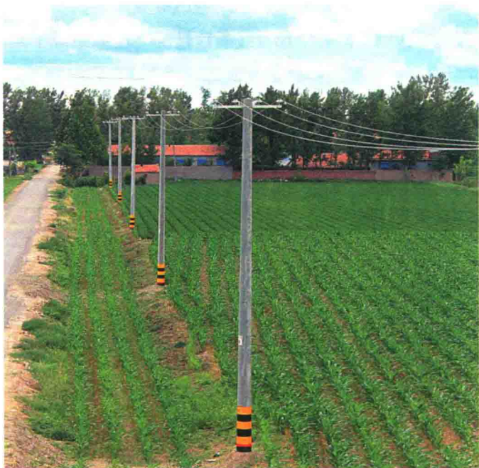
图 1-23 380V 导线弧垂
