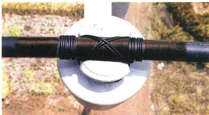
图 1-24 直线杆导线固定
