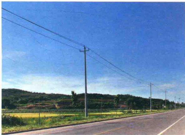
图 1-22 10kV 导线弧垂
