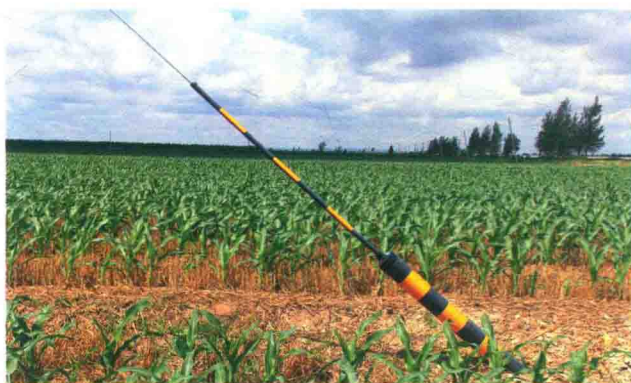
图 1-19 拉线护套安装
