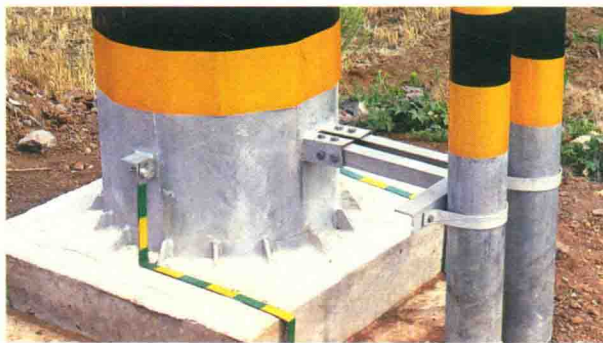
图 1-28 钢管杆杆身双接地点接地
