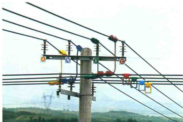
图 1-27 380V 导线连接
