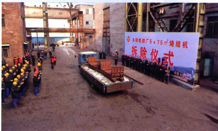
■ 12月26日 本钢集团举行板材炼铁厂5×75m²烧结机拆除仪式
