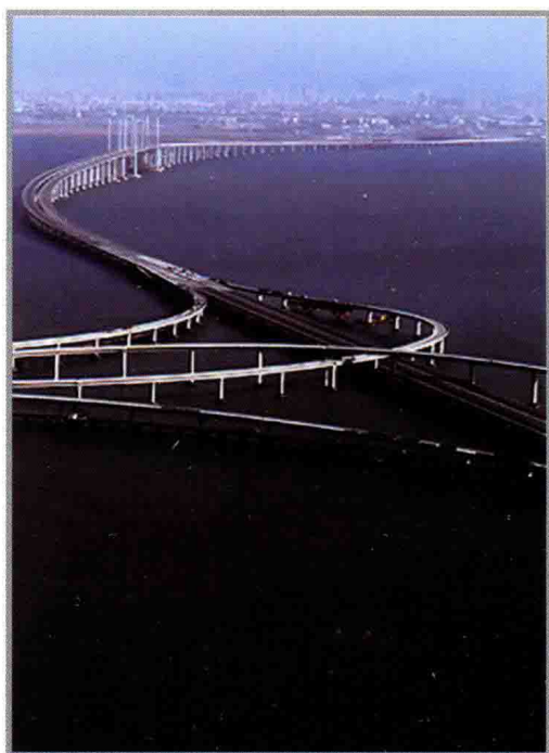
最长的跨海大桥——青岛海湾大桥
