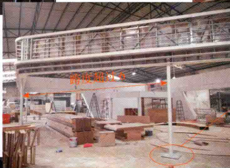
图 2-11 结构柱子安装
