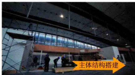
图 2-5 展馆主体结构搭建
