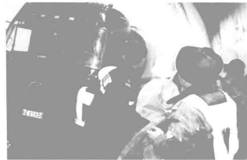
d) 千家砭隧道火灾扑救现场
