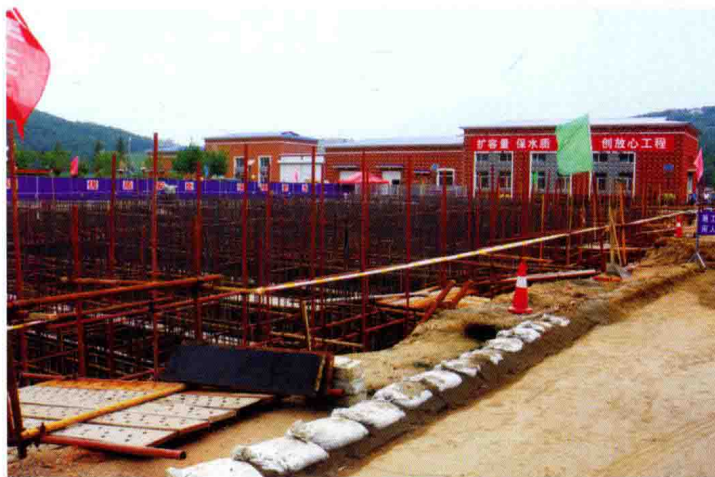
5月1日，柳河县净水厂改扩建二期工程开工建设 (唐云鹏 提供)
