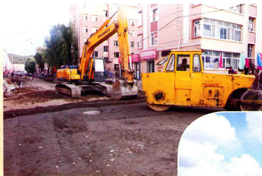
5月5日,前进路城市路网改造工程开工 (唐云鹏提供)
