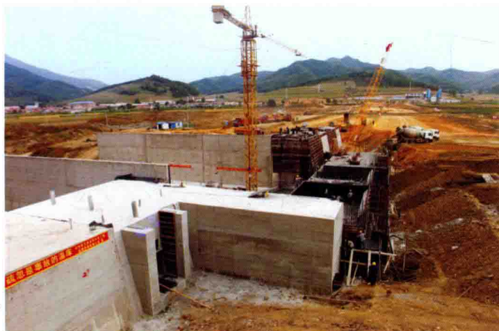
3月12日，大迫子水库水源工程正式开工建设 (唐云鹏 提供)
