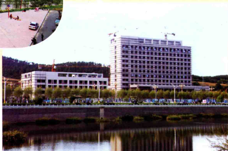
10月，河北新区综合性医院主体竣工 (唐云鹏 提供)
