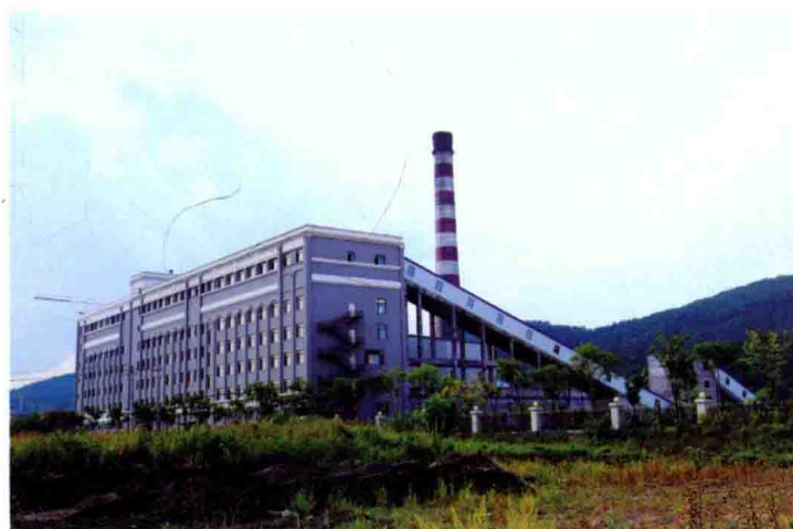
11月15日，河北新区供热二期扩能工程竣工 (庄瑞春 摄)
