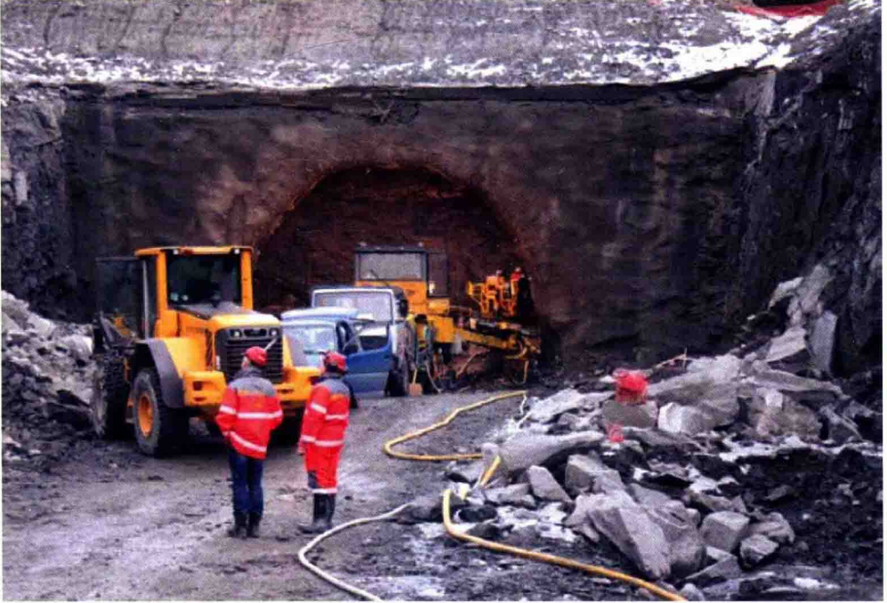
图 1-1 修建中的 Eiksund 海底隧道 (照片由挪威公路管理局 Svein Skeide 提供)
