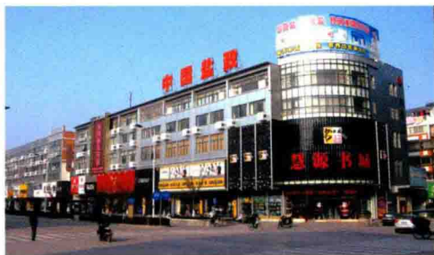
96.如皋市盐务局大楼
