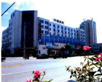
98.海安县盐务局大楼
