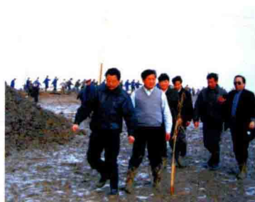
64.南通市副市长陈华汝、秘书长陆兴达与如东县领导视察如东盐场围海扩建工程
