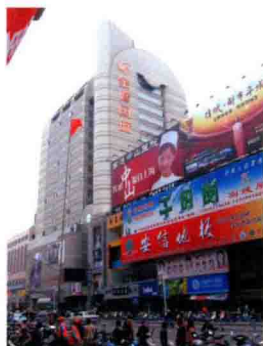
86.南通市盐务局盐业公司南大街银座大厦第12层办公楼
