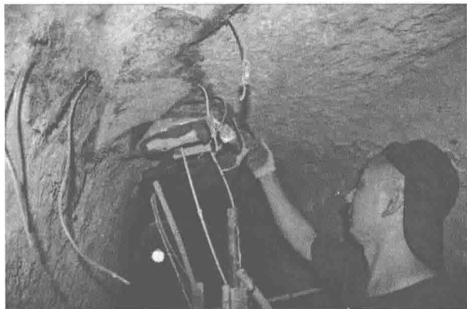
图3 58号窟空鼓壁画修复（植入注浆管）
