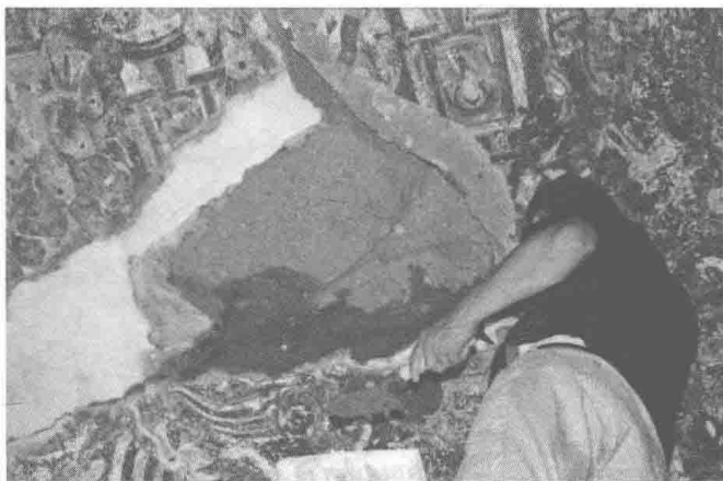
图7 注射器方法加固主室顶部风化砂岩体
