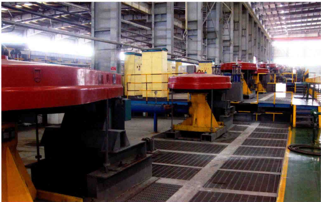
中国黄金乌努格吐山铜钼矿项目 KYF-160 浮选机使用现场
