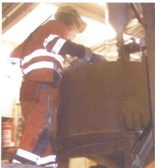
注浆混合料搅拌
