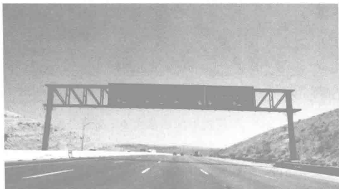
图 2-1 改扩建后的美国 15 号高速公路
