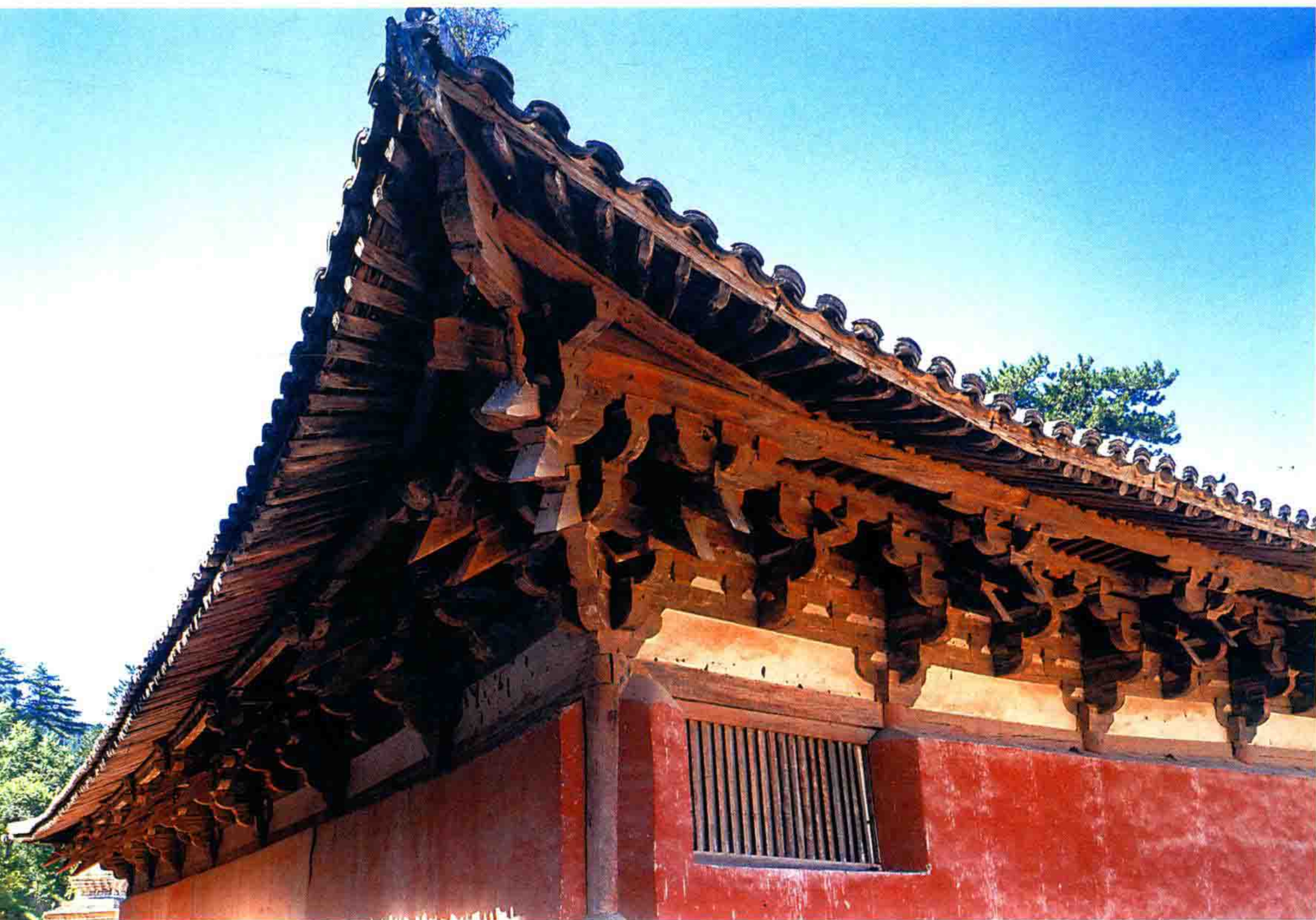
图1-3 山西五台山佛光寺大殿外檐斗拱（唐代） 斗拱是由许多“斗”、“栱”、“昂”等短小木块组合在一起的建筑构件。主要位于檐下，起挑檐作用，并将上部重量通过这些小木块，层层向下传递到梁柱上。
