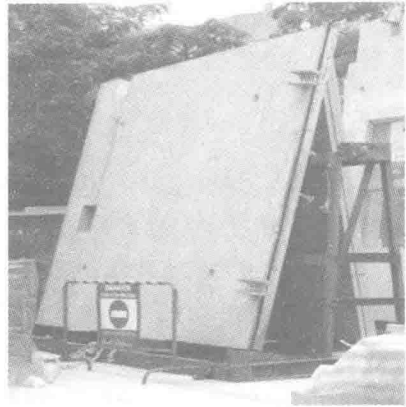
图 1.3-2 预制外挂墙板专用堆置架示例
