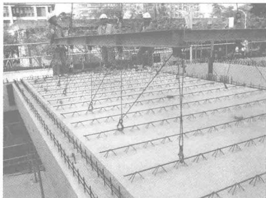
图 1.3-4 预制楼板起吊用吊架示例
