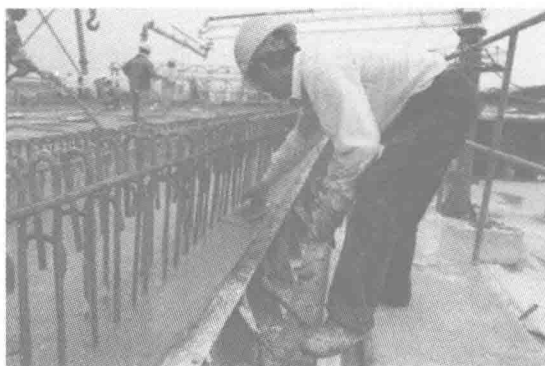
图 2.2-1 施工现场预制
