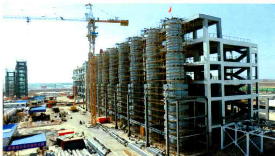
总投资40亿元的兴化大化工项目建设现场
