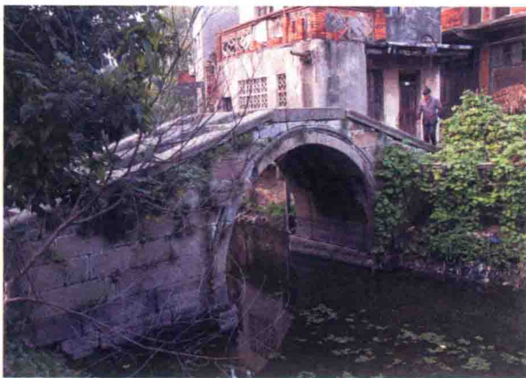
江苏省宜兴市周铁镇洋溪村洋溪桥
