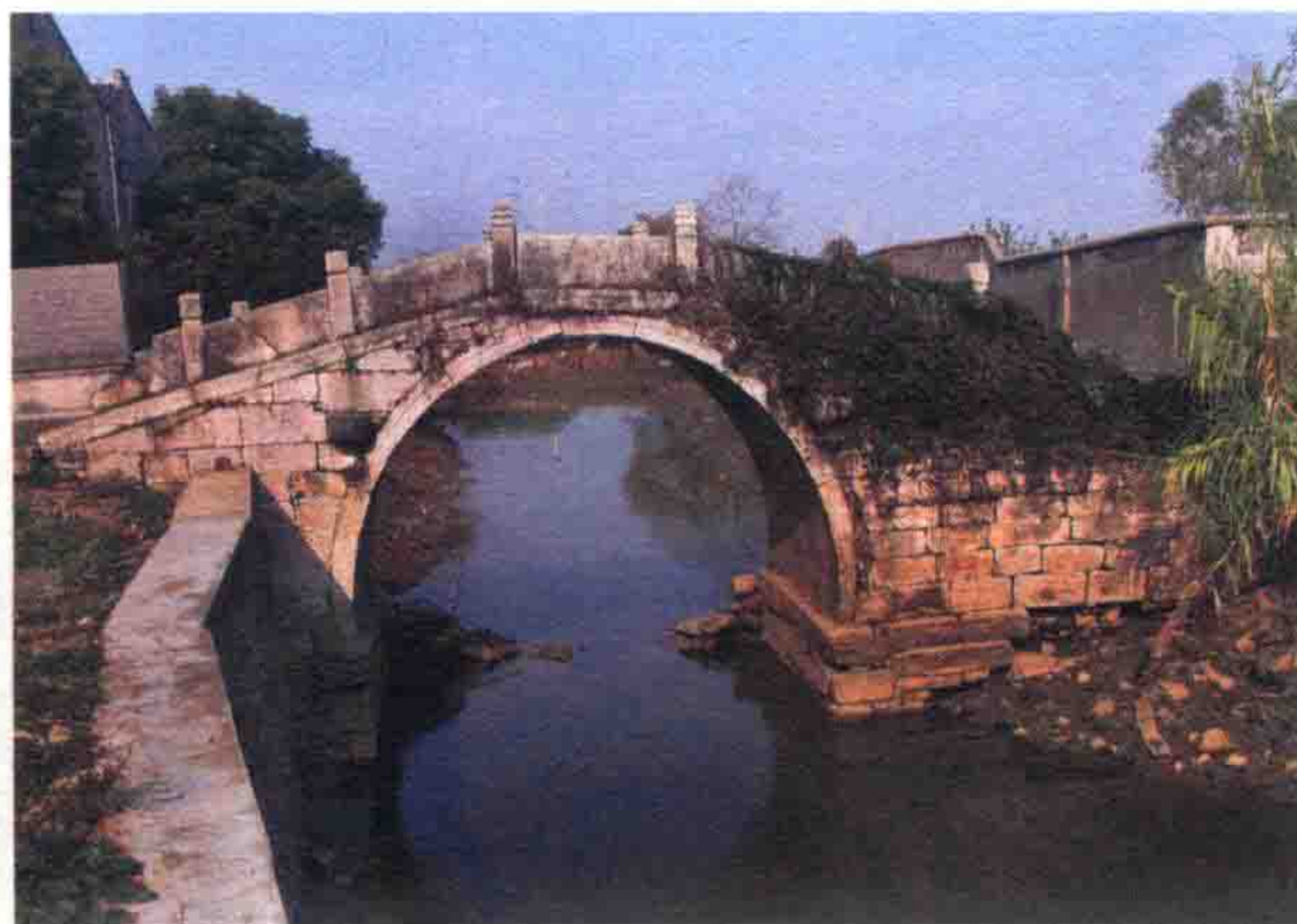
江苏省宜兴市高塍镇毫村永安桥
