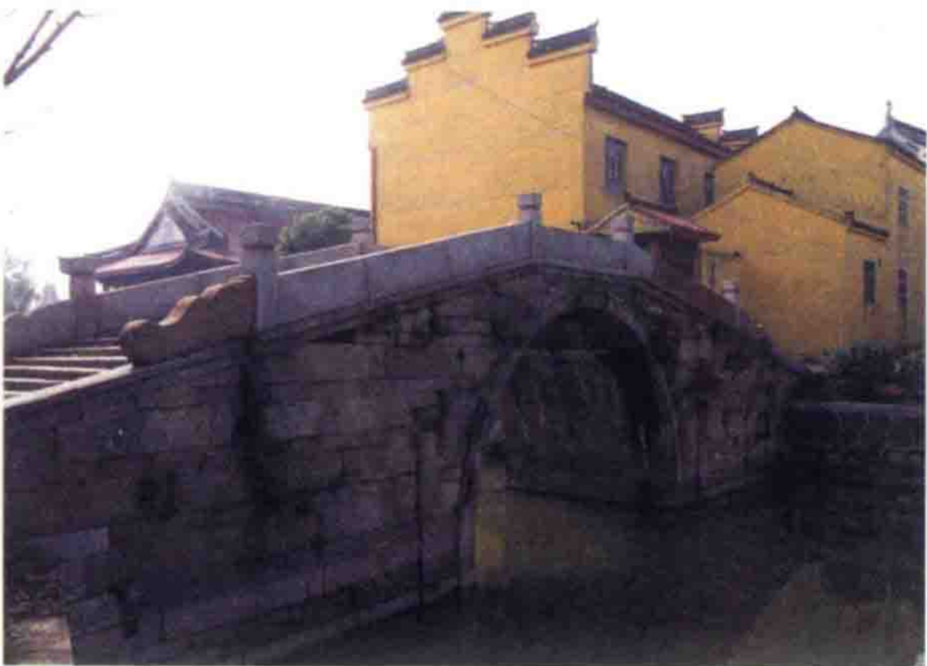
江苏省宜兴市周铁镇王茂村万园桥
