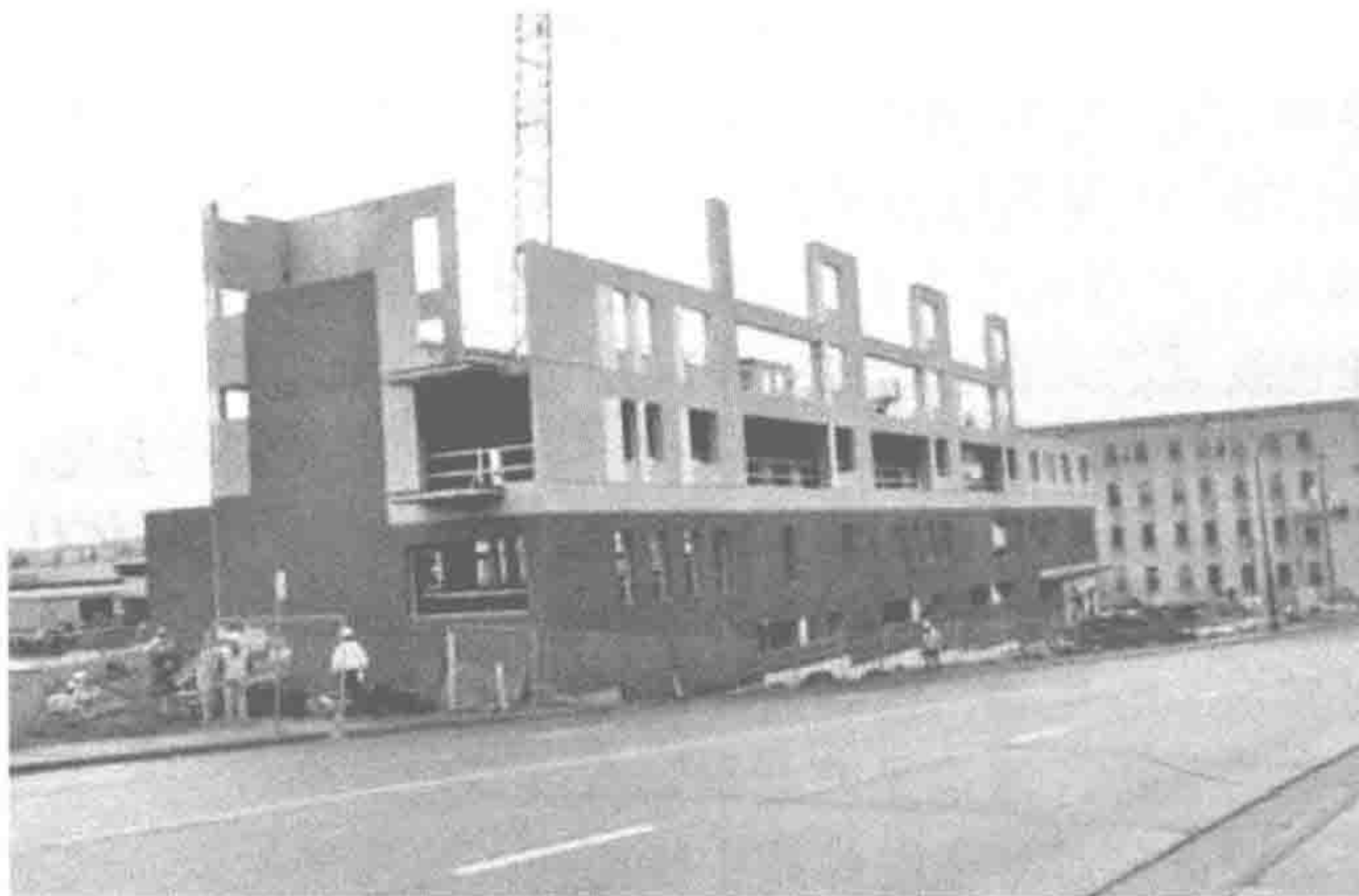
图 1-3 预制装配式混凝土结构住宅
