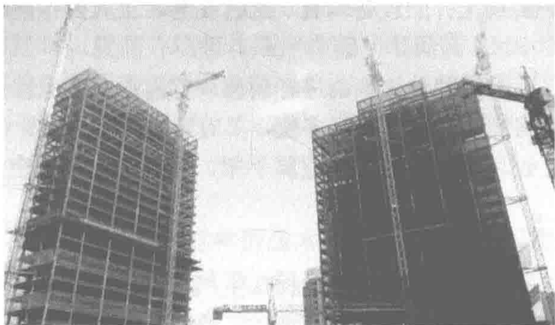
图 1-5 多高层装配式钢结构住宅
