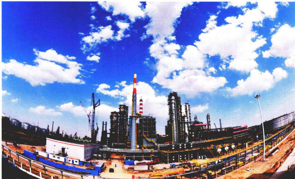
中国石油工程建设公司承建的宁夏石化公司500万吨/年炼油改扩建工程，是国内首个工厂化EPC总承包项目
