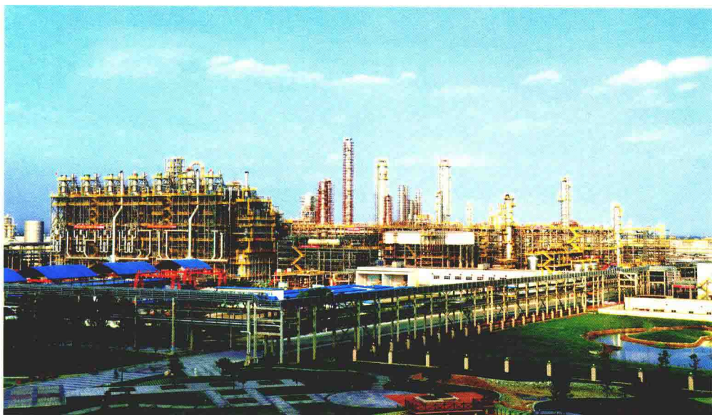
中国石油一建、中国石油七建承建的四川石化公司 80 万吨 / 年乙烯装置
