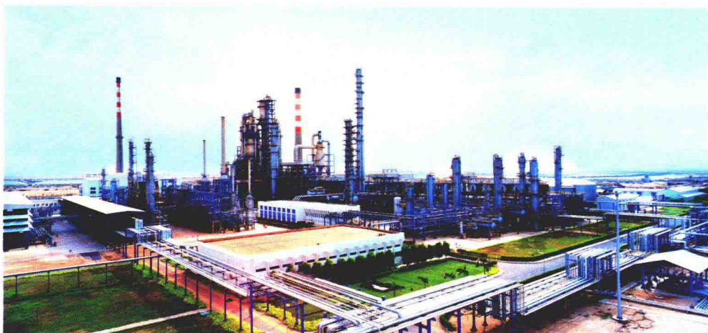
中国石油工程建设公司 EPC 总承包的苏丹喀土穆 500 万吨/年炼油扩建工程，获中国建设工程（境外工程）鲁班奖
