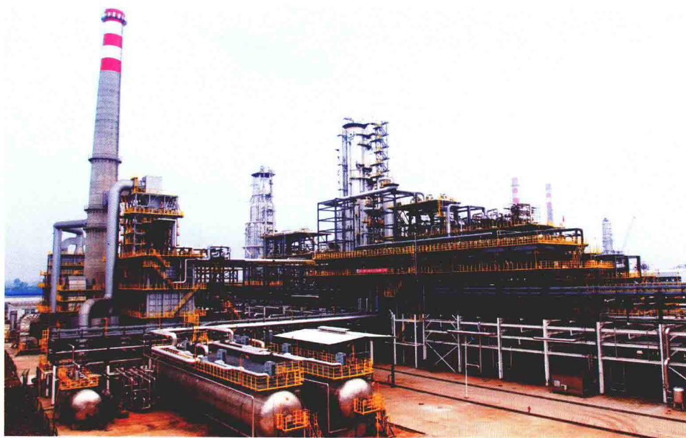
华东设计分公司 EPC 总承包的四川石化公司 1000 万吨 / 年常减压蒸馏装置
