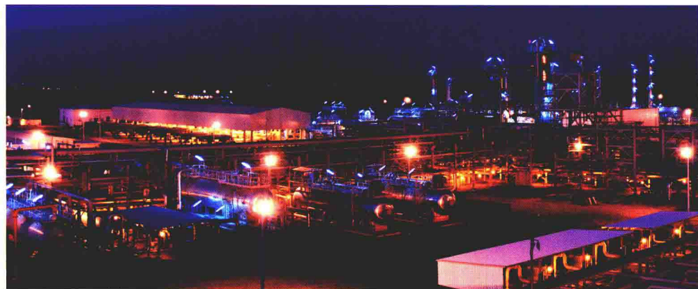
中国石油工程建设公司 EPC 总承包的伊拉克艾哈代布原油中心 处理站被誉为“中东标志性项目”
