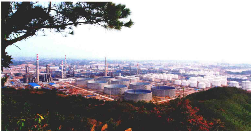
中国石油工程建设公司总体设计并承担主要核心装置设计、施工任务的中国石油首个千万吨级炼油项目——广西石化公司1000万吨/年炼油项目
