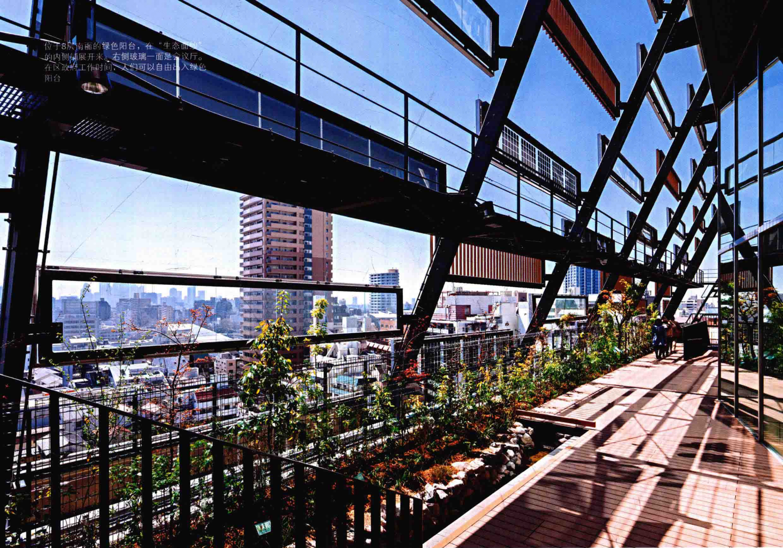
右侧墙壁还充当了雨水管的作用，可以将各种植物提供水分。由于进行墙面绿化，又被称作“绿色管道”。在旁边的楼梯上可以俯瞰整个8栋。
