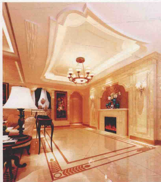
顶面 [ 石膏板造型暗藏灯带 ]
