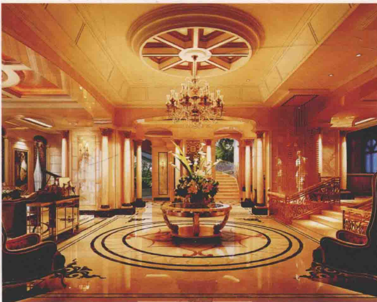
顶面 [ 石膏板造型 + 石膏线条描金 ]
