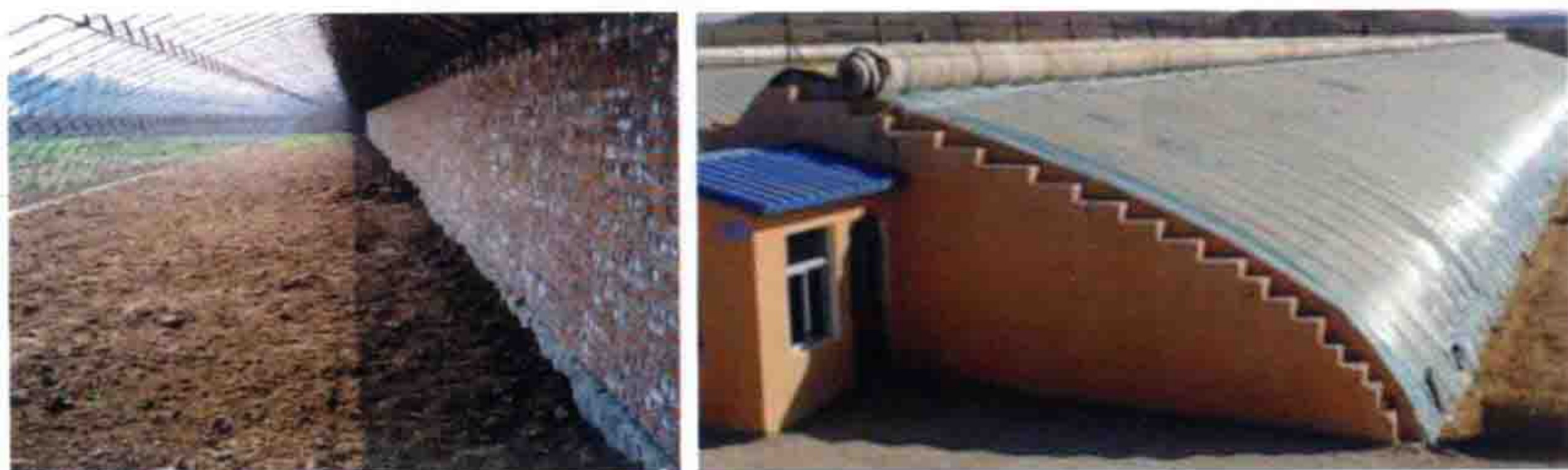
彩图 1 钢架结构日光温室
