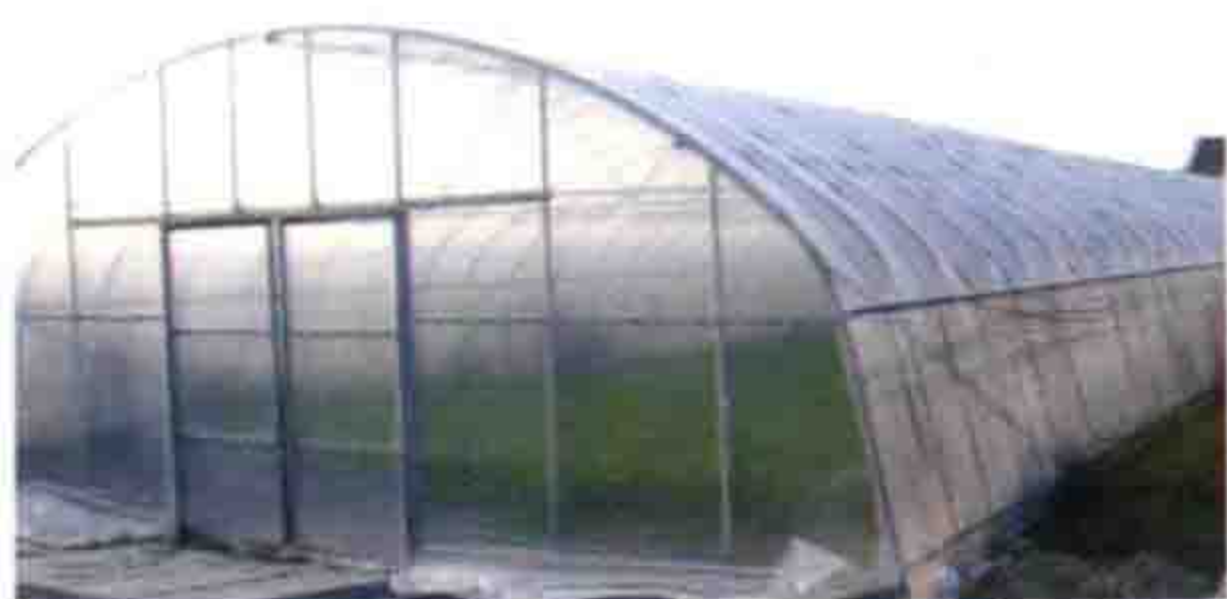
彩图 4 装配式钢管结构单栋大棚
