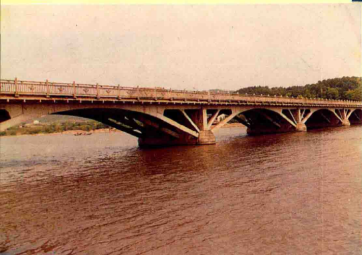
宜春袁河大桥
