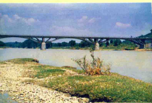
上高蛇尾大桥
