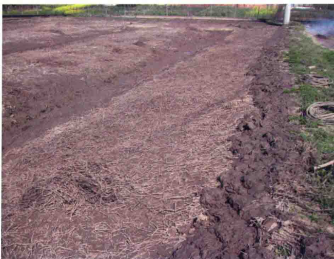
清除养殖池塘中的淤泥
