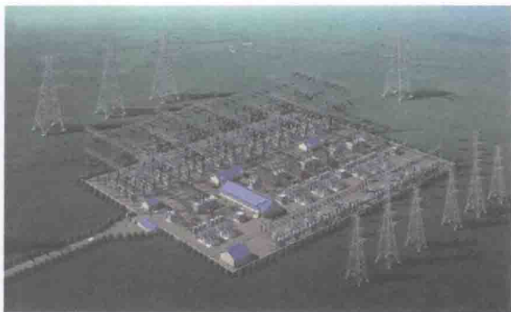
图 1-2 500kV 智能变电站
