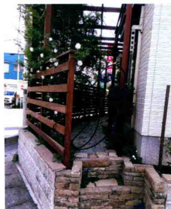
① 拆掉原有的网状栅栏，换成通风良好的木质栅栏。
