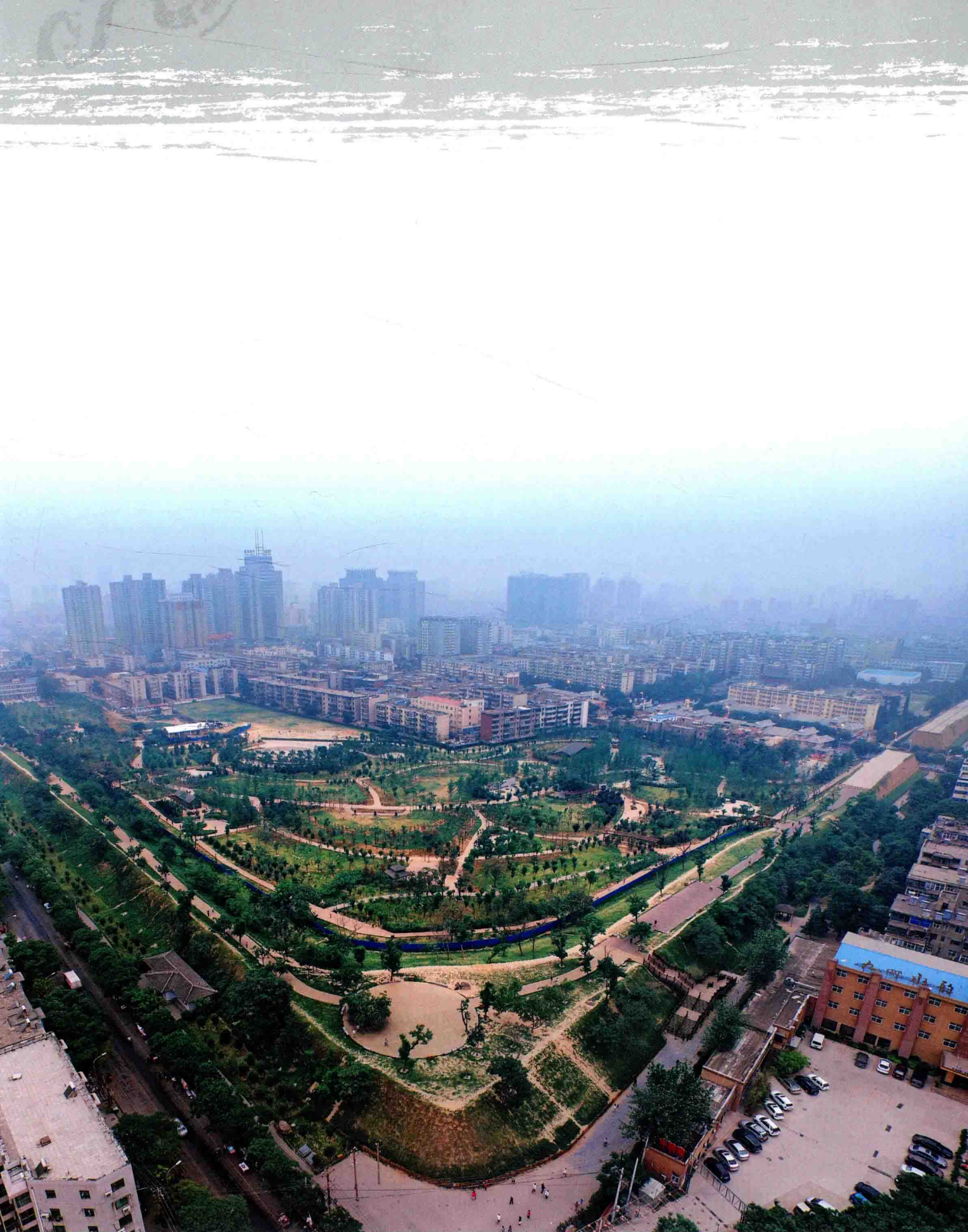
东南城垣抢险加固工程航拍图
