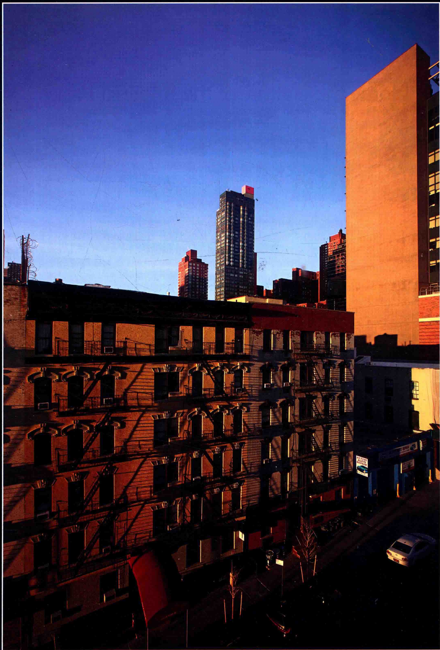
20世纪美国纽约所建住区室外防火楼梯一览（摄影/金磊）
