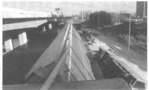
图 1.1-8 哈尔滨阳明滩大桥引桥匝道
