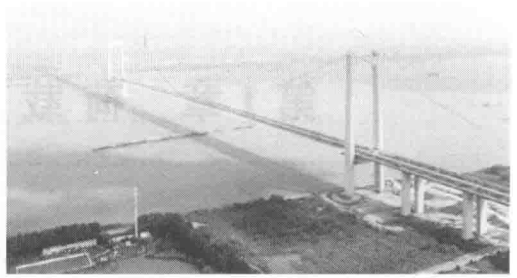
图 1.1-6 泰州长江公路大桥
