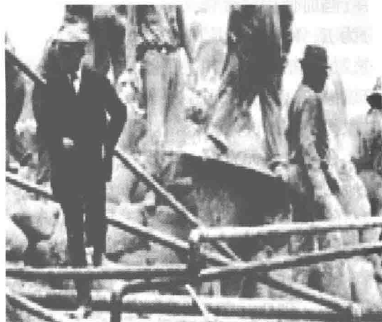
图 1-4 早期的固井施工现场
