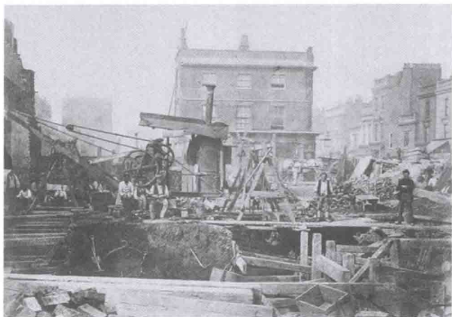
世界上第一条地铁——伦敦“大都会”线施工
