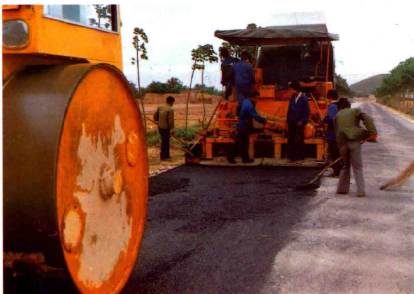
▲摊铺机正在铺油路
