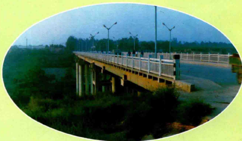
三原临履清峪河桥
