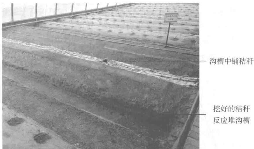
图 2-1 挖内置式秸秆反应沟槽与秸秆铺施方法
