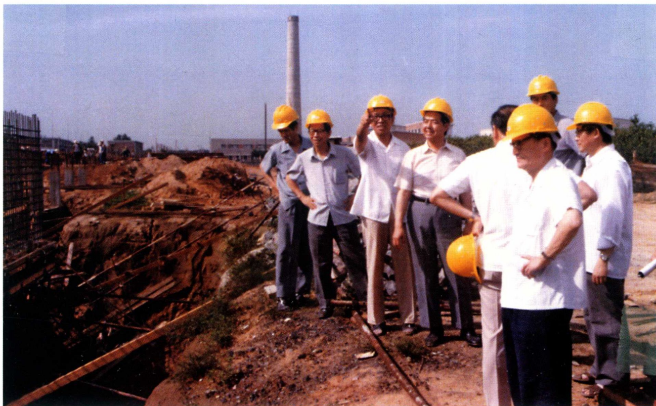
1985年6月,李政道(左四)在北京正负电子对撞机工程工地听取技术人员介绍工程进展情况。
